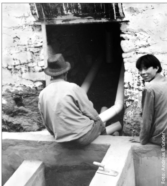
Lehrer und Auszubildender beim Bau einer Klärgrube: alte Tradition mit moderner Technik
