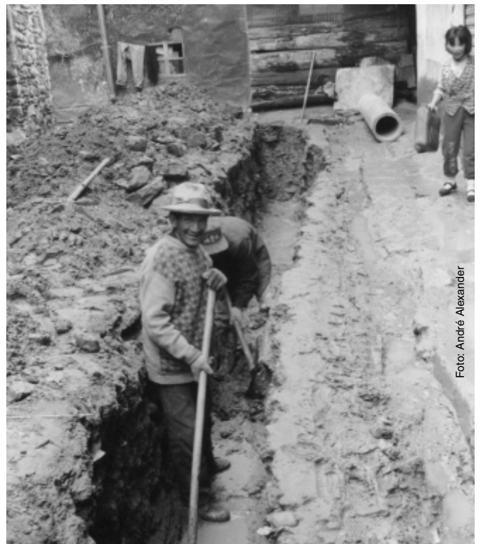
THF-Arbeiter verlegen Abwasserleitungen in der Altstadt von Lhasa.
