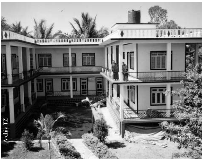
In Haus 14 konnte ein zweites Geschoss gebaut werden, so dass es jetzt doppelt so viel Platz für Mönchsunterkünfte bietet.
